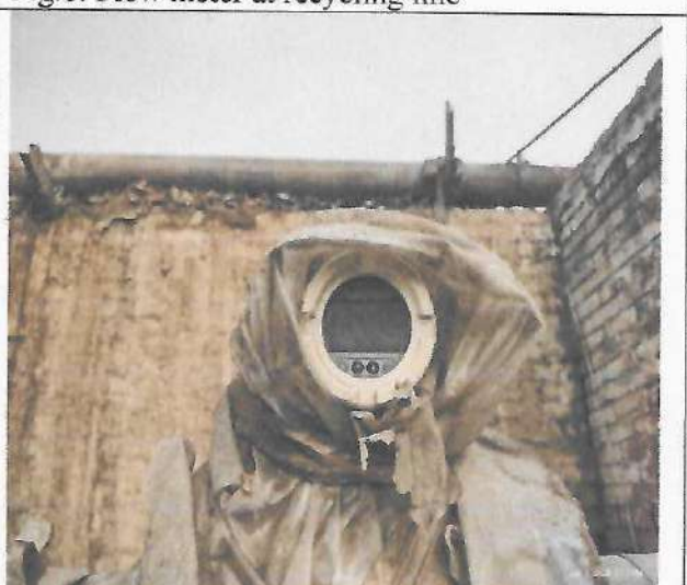
Fig.10: ETP energy meter
